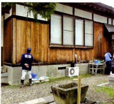
③社務所壁カビ清掃作業
